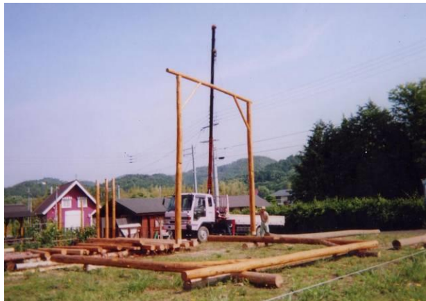
図5 6、7mの柱は空き地で組立て鳥居形のまま架設した。
