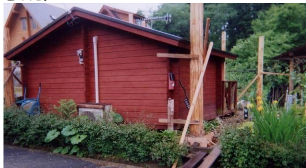
図4 3m程度の柱は1本ずつ立て固定した。
