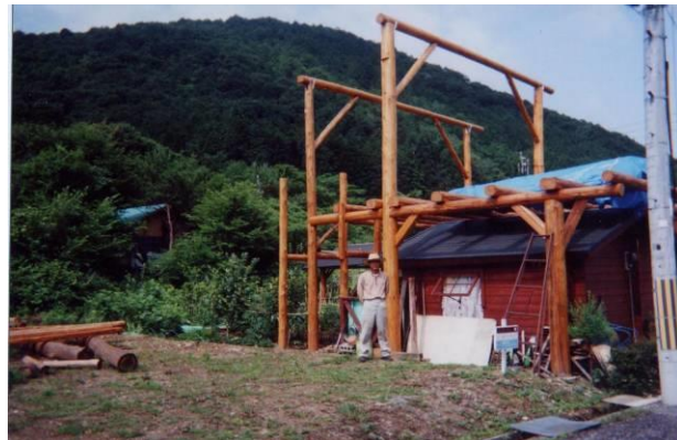
図6 方杖、火打ちを取り付け梁をならべた。
