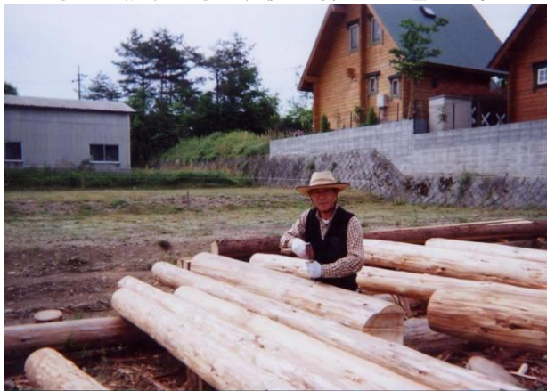
図2 皮を剥ぎ、のこぎりで切断しドリルやのみで加工をした。
