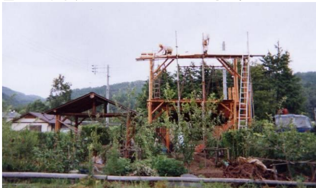
図 9 ベランダの屋根の施行。6～7mの高さは鳶でも恐がる高さらしい。ちょうどこの高さの屋根を山中さんと2人で施工した。
