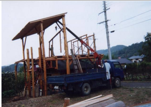
図 11 骨組み。足場がなく柱の上に梁を乗せられないため梁に4の柱をぶら下げたままで架設した。
