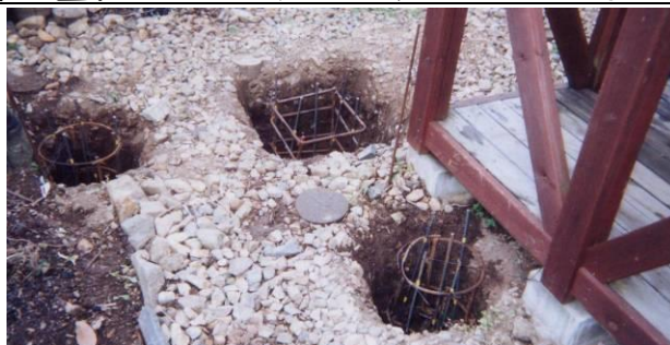
図3 柱の基礎・建築ではブロックの上に柱を乗せるだけのものが多い。私は穴を掘り、鉄筋コンクリートにして25cm埋め込んだ。土木屋の発想だ。コンクリートは2回打ちとなり、高さを出すのに苦労をした。
