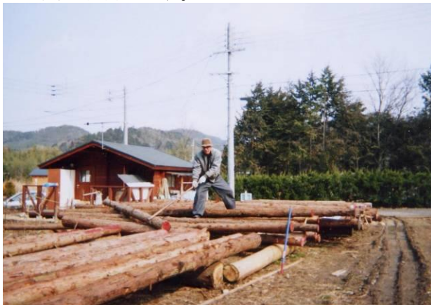
図1 山の持ち主の許可を得て切りだした桧を隣の空き地に仮置きし、使う順に並べ替える。
